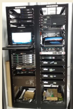
映像・音声・制御装置ラック実装
