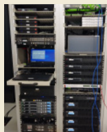
映像・音声・制御装置ラック実装
