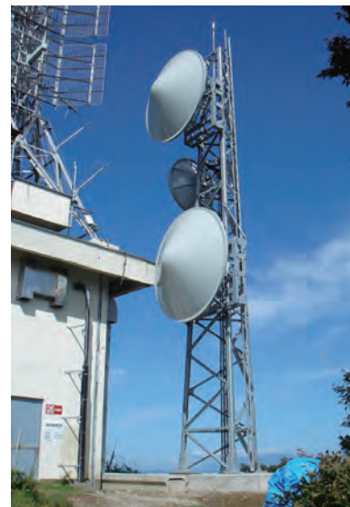
ID鉄塔(当社開発の自立式三角鉄塔)
