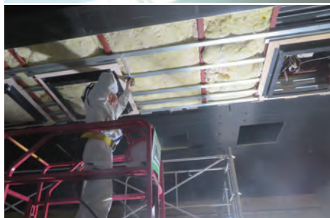
NHK仙台新放送会館公開スタジオ・施工作業例
