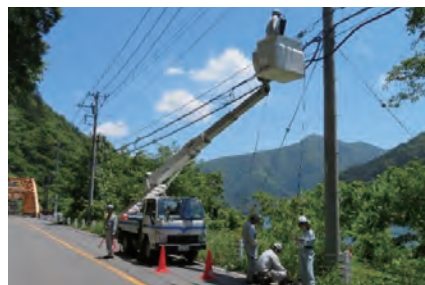
テレビ共同受信施設 光ケーブル敷設作業
