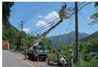
テレビ共同受信施設 光ケーブル敷設作業
