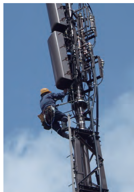
地上放送の高度化実証実験 水平・垂直両偏波（MIMO）対応送信アンテナの調整作業
