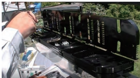
テレビ共同受信施設 光ケーブル接続作業
