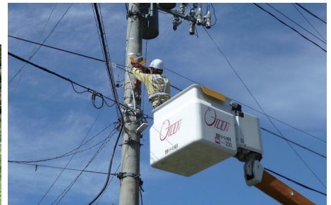
テレビ共聴設備幹線工事
